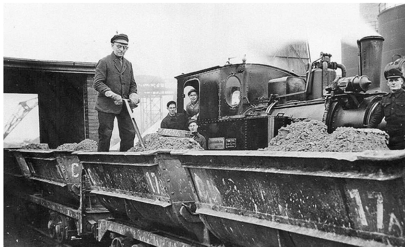
Konzentrat-Probenehmer an der Gleiswaage in der Hütte Oker Repro Sammlung: J. Fricke
