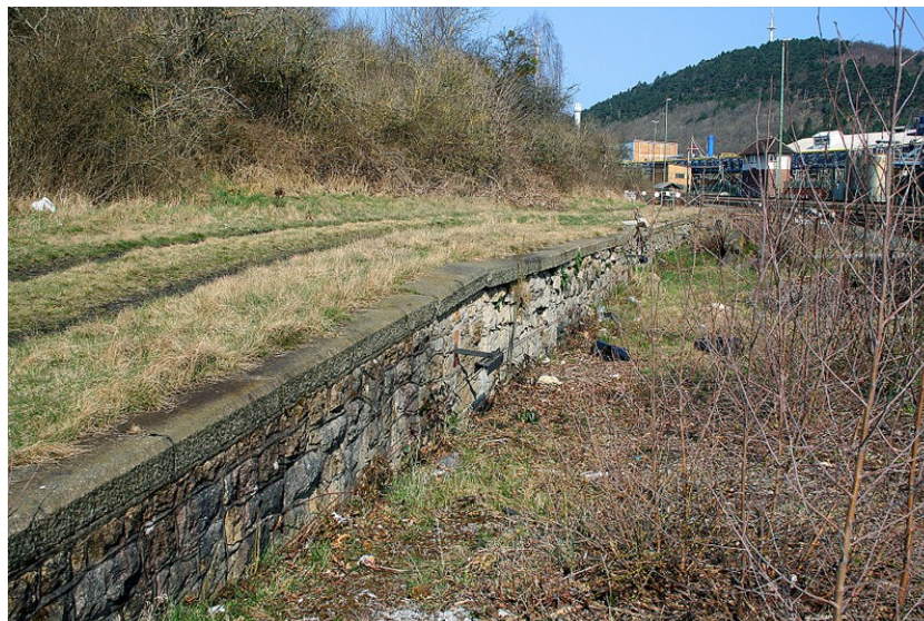
Ob es sich bei dieser Rampe um den Unterbau der alten Verladung handelt, ist nicht mehr nachvollziehbar. Sie ist jedoch isoliert und nicht mit Straßenfahrzeugen erreichbar. Foto: J. Fricke (2015)
