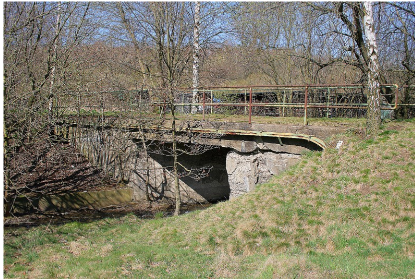
Brücke über den Gelmkebach in Oker Foto: J. Fricke (2015)
