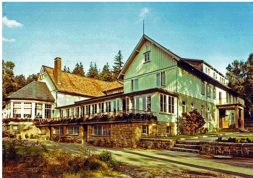
Gasthaus Bleiche, welches Anfang der 1960er Jahre abgerissen wurde. Foto: INNtegrativ, Sammlung: J. Fricke
