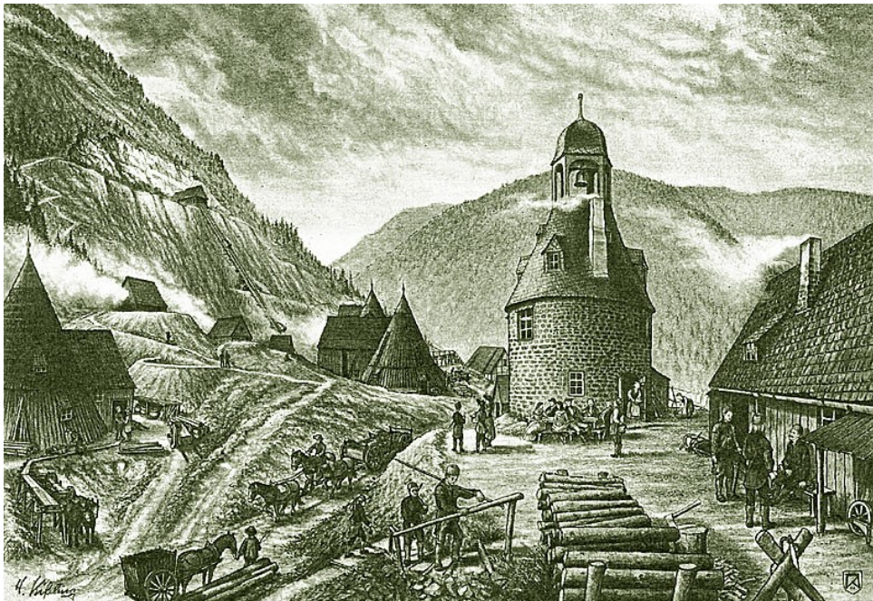
Das Gaipelplateau auf dem Niveau des Maltermeister Turms am Rammelsberg ca. 1780. Links unten zwei Höhlenwagen zum Erztransport (2- und 4-rädrig) Zeichnung: Hermann Kießling (2002)
