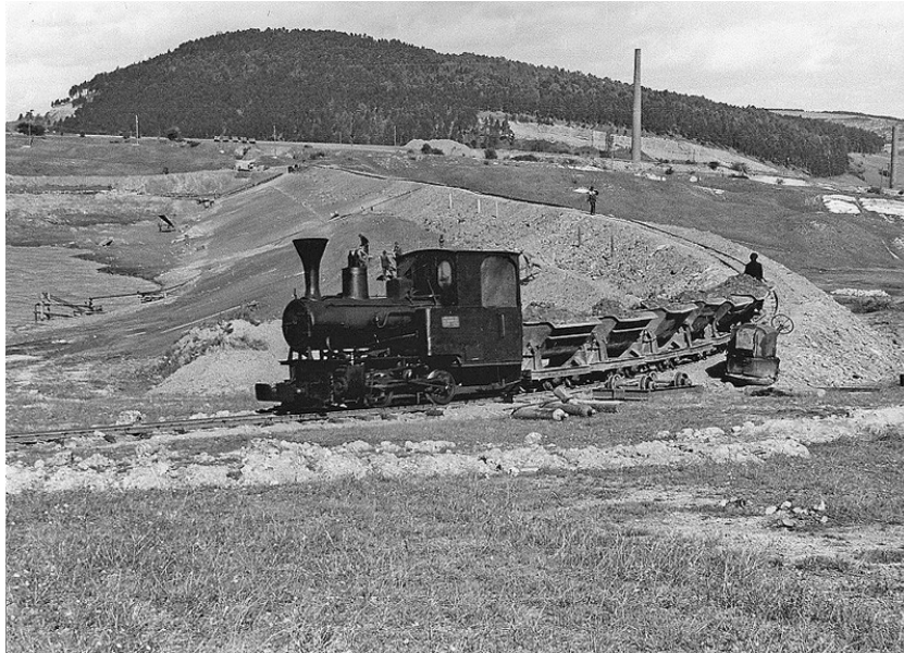
Dammbau mit Feldbahn der Firma Holzmann Repro Sammlung: J. Fricke
