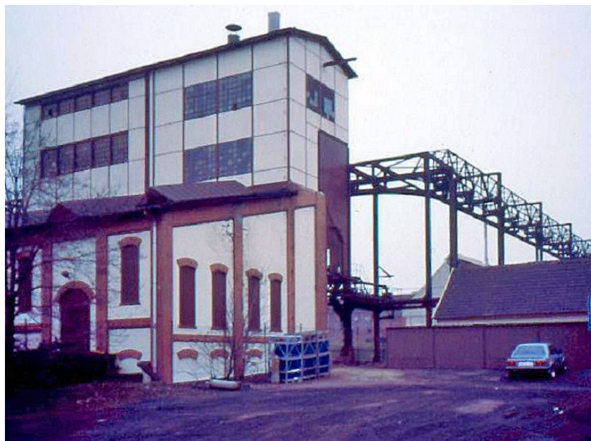
Gebäude der Erzzerkleinerung Foto: M. Becker
