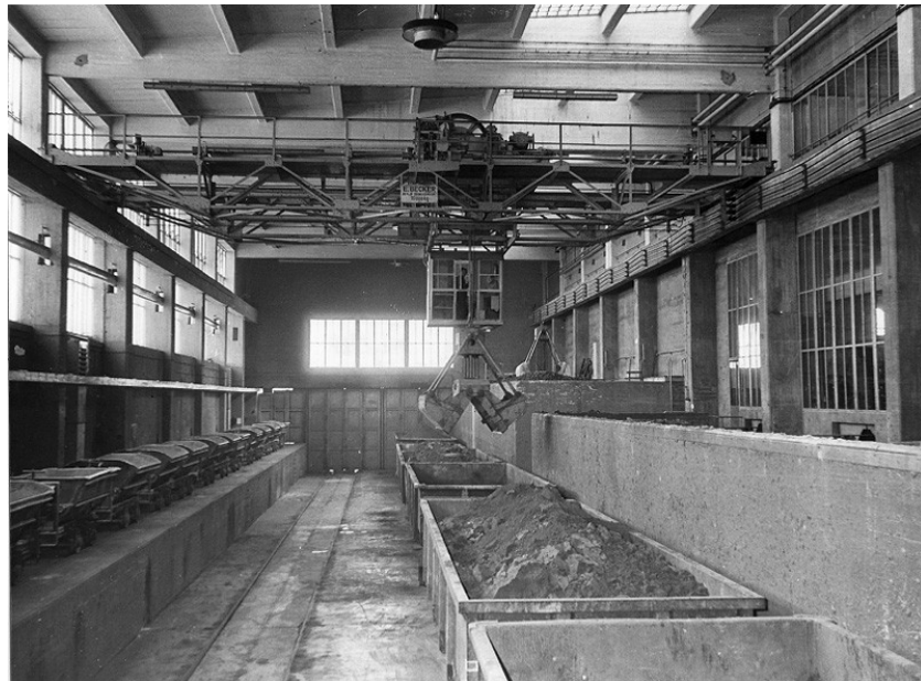
Umladehalle mit schmalspurigen Förderwagen und normalspurigen Konzentratwagen. Repro Sammlung: J. Fricke
