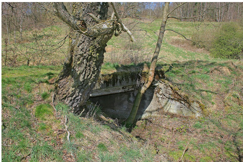
Der östliche Durchlass des Gelmkebachs Alle Fotos: J. Fricke (2015)
