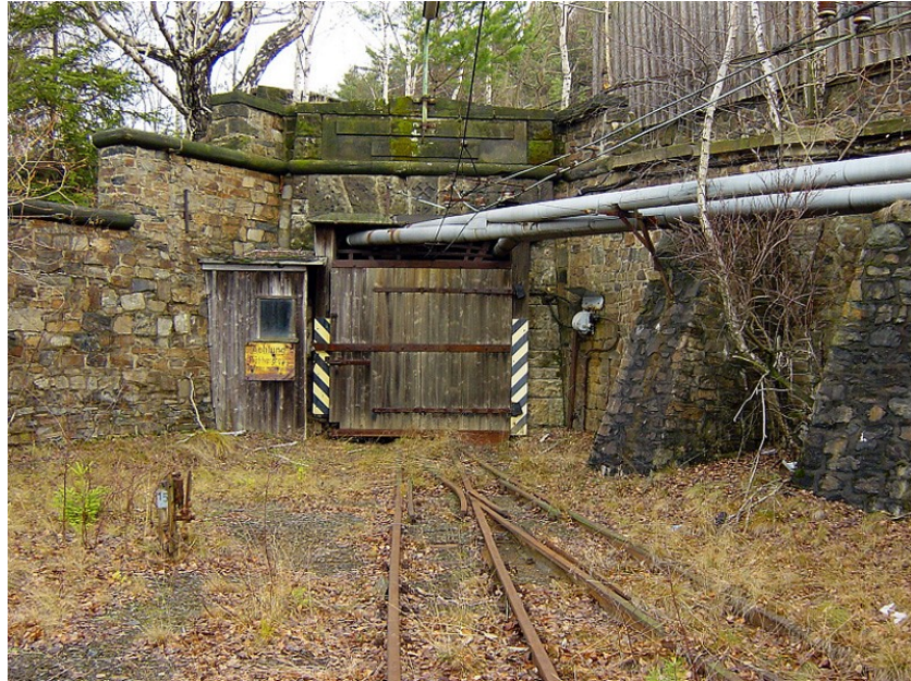
Grubenseitiges Mundloch des Gelenbecker Stollens
