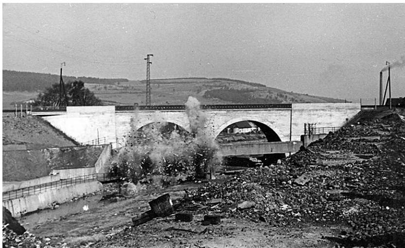
Sprengung der Okerbrücke
