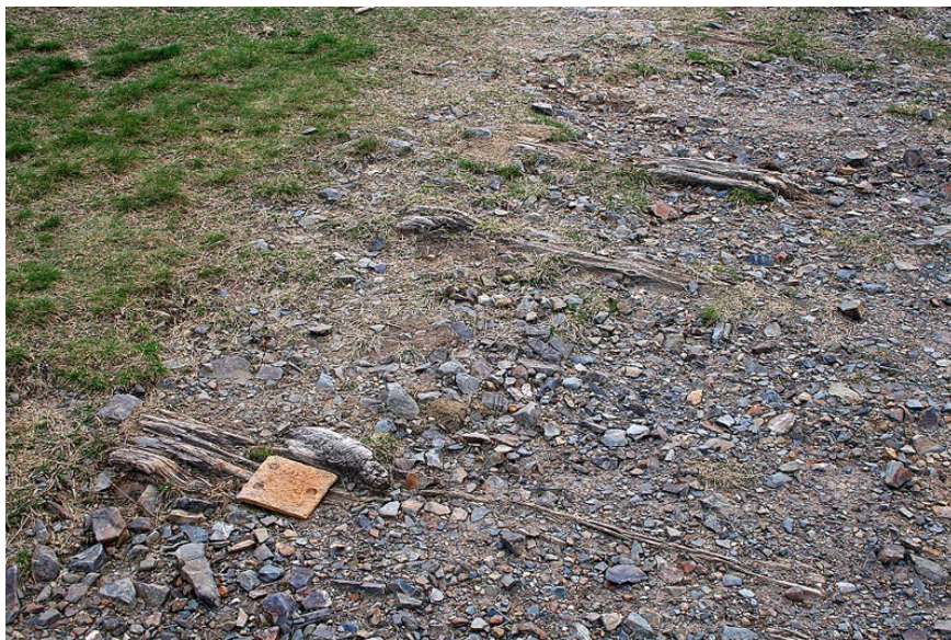
Schwellenreste mit Unterlagsplatte am Blauen Haufen. Foto: J. Fricke (2015)
