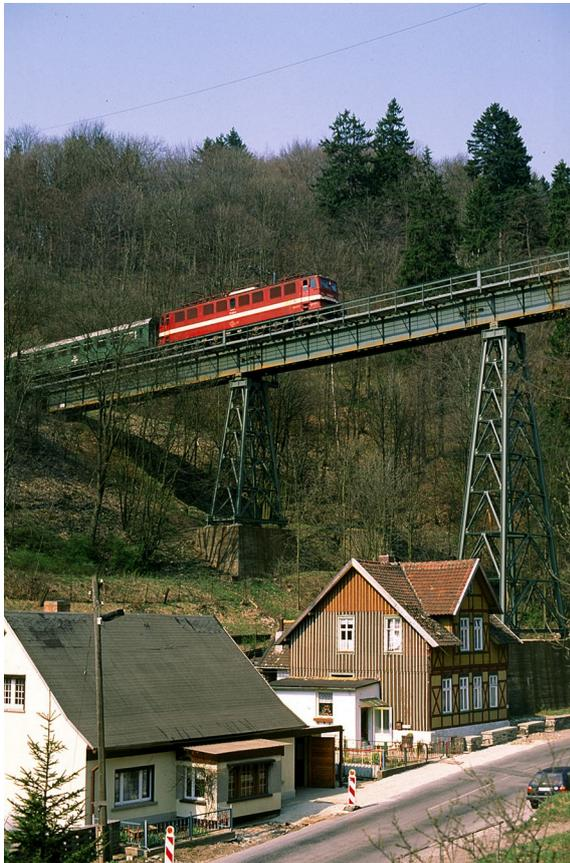
Das größte Bauwerk der neuen Strecke war das 29m hohe und 99m lange Viadukt bei Neuwerk, welches zwischen den zwei Tunneln "Krumme Grube", mit einer Länge von 307m auf der Hüttenroder Seite, sowie "Nebelholz" mit einer Länge von 90m erbaut wurde. Zwei weitere Brückenbauwerke waren darüber hinaus erforderlich um die Straße von Hüttenrode nach Rübeland zu queren. (Aufnahme aus den 1990er Jahren)
